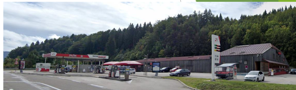
Supermarché Intermarché aux Hôpitaux-Neufs (source : Street view - 2019)
